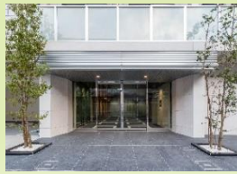
GENOVIA Higashi Mukojima skygarden
