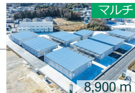
● プロロジスパーク古河6 (茨城県古河市) 2024年12月竣工
