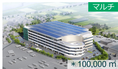
● プロロジスパーク基山2 (佐賀県三養基郡) 2028年末竣工予定
