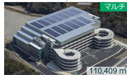
● プロロジスパーク八千代2 (千葉県八千代市) 2025年4月竣工
