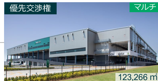
● プロロジスパーク古河4 (茨城県古河市) 2023年5月竣工
