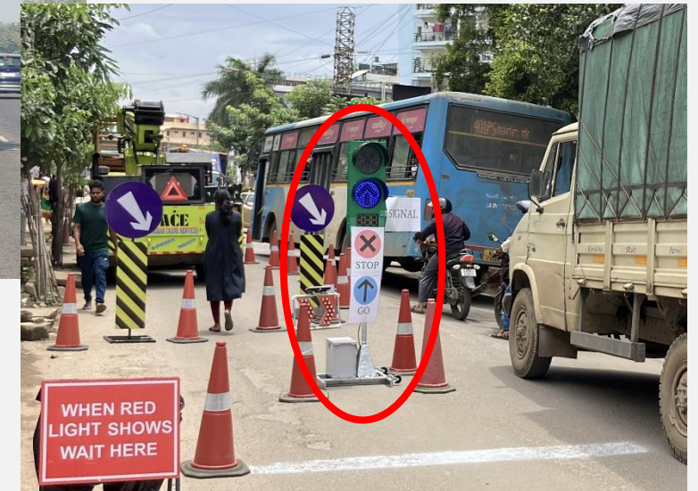
▼インフォメックス松本製仮設信号機を用いた実証実験 (インド・ベンガルール市内)
